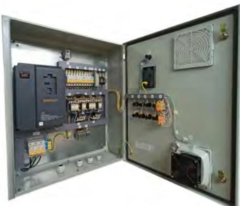
Предназначен для постоянного поддержания заданного давления воды в системе, при минимальных потерях в двигателе и экономии электроэнергии.
