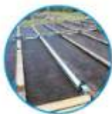
Очистка сточных вод
