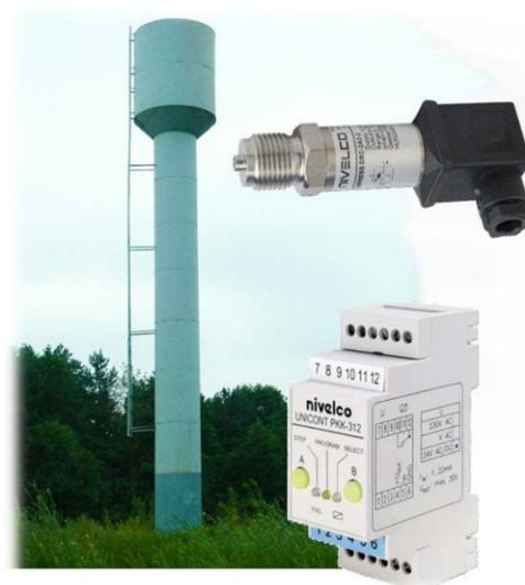
Удачная конструкция Рожновского 30-х годов прошлого столетия, по сей день служащая верой и правдой, включает переливную трубу, как элемент минимальной автоматизации, предотвращающий переполнение башни. При визуальном контроле за переливом все же невозможно избежать потерь артезианской воды и, соответственно, энергии, затраченной на ее подъем.
