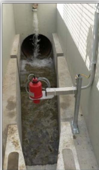
**Принцип работы:** поток жидкости в лотке Паршалла ограничивается путем сужения, по причине чего уровень в секции за горловиной повышается. Скорость течения увеличивается за счет перепада уровня жидкости в горловине. Поскольку уровень в лотке Паршалла изменяется пропорционально потоку, расход жидкости вычисляется по измеряемому уровню потока.
