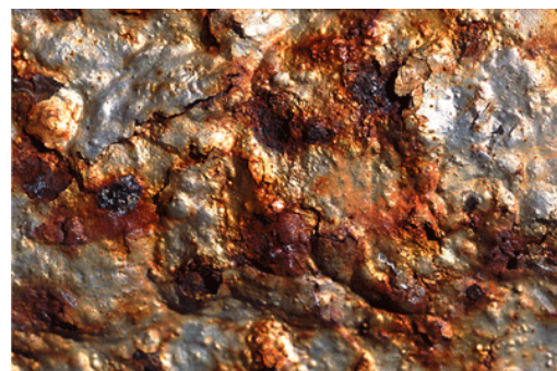
Пример коррозии нержавеющей стали 1.4435
