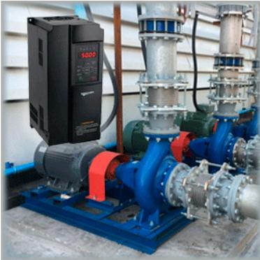
Каскадное управление насосами – эффективное решение для трубопроводных систем и магистралей, в которых давление жидкостей и их расход носят переменный характер. Способ подразумевает под собой несколько насосов, установленных параллельно. Включение насосов осуществляется при необходимости с помощью головного устройства, которое выполняет алгоритм каскадного управления насосами.
